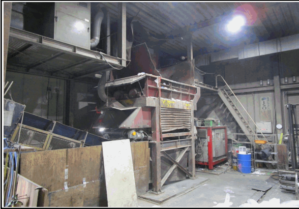
①施設の外観(施設名称: 破碎処理場)
